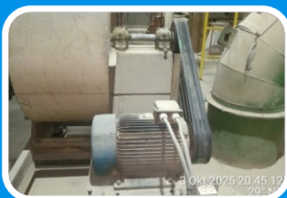
INSTALASI MOTOR Biringkanaya - Makasar - SulSel 3 Oktober 2025
