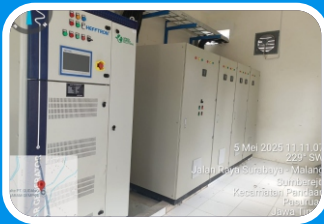
INSTALASI PANEL LVMDP Buduran Sidoarjo 22 Februari 2025
