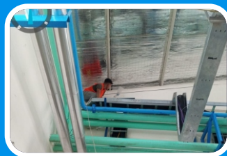
INSTALASI PLUMBING Pandaan - Pasuruan 24 Juni 2025
